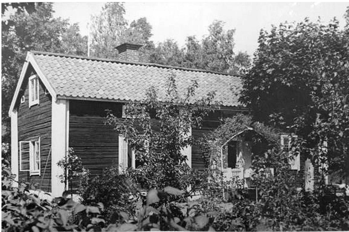
Stamfastigheten Sofiehill som den en gång såg ut.
